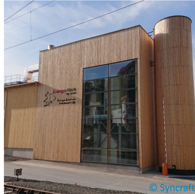
Holzvergassungsanlage in Stöcken (AT)
