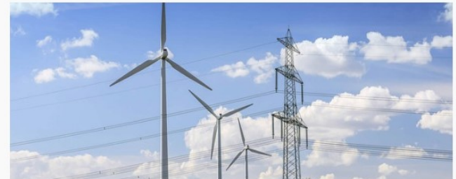
Windräder und Strommast
