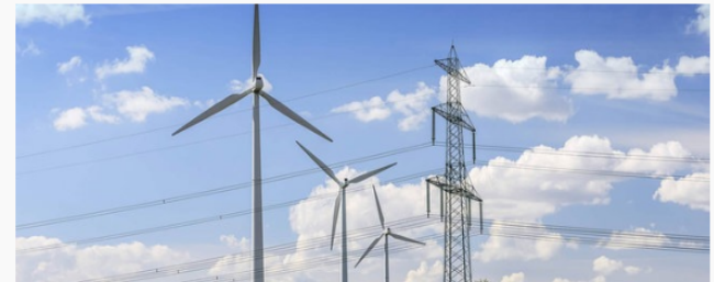
Windräder und Strommast
